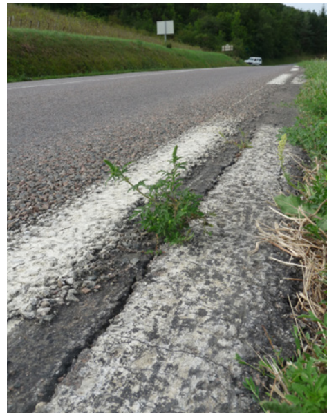
Ambroisie en bordure de revêtement
